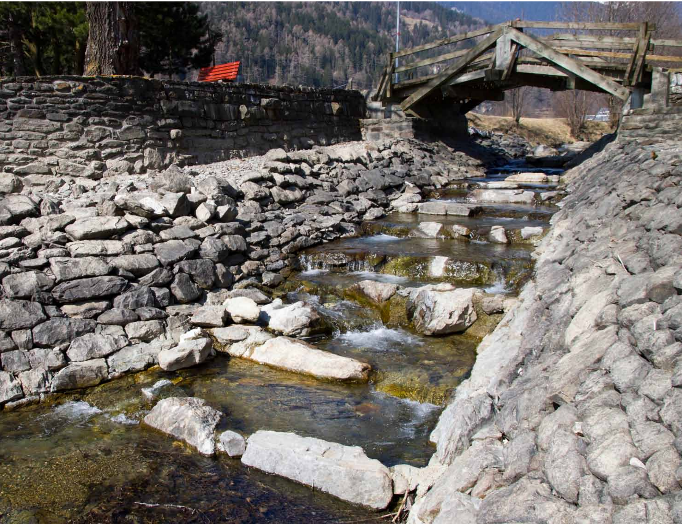
Rampa di risalita. Blockrampe.
