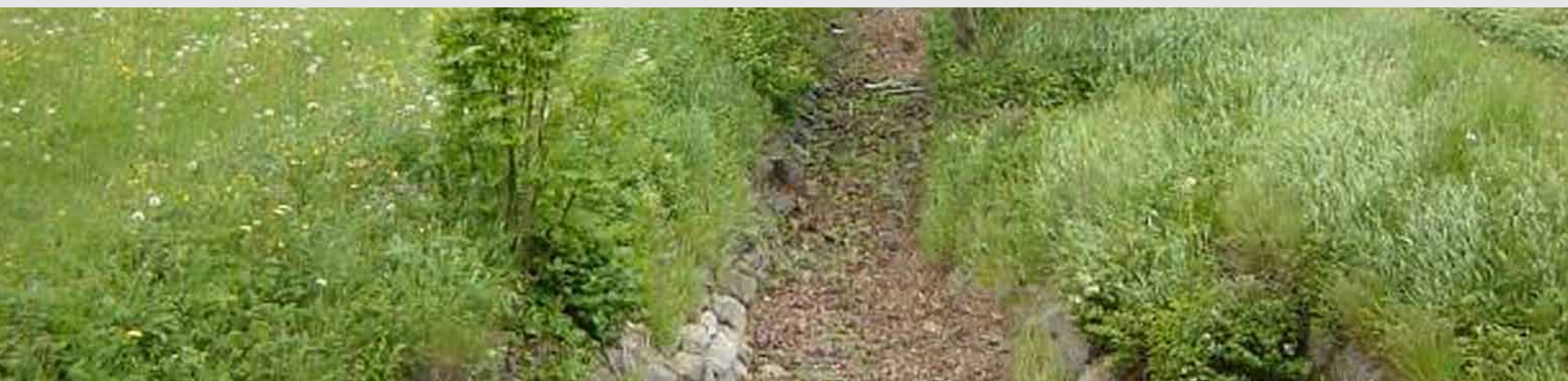
Stato iniziale dell'Acquasela prima della rivitalizzazione. Trockengelegter Acquasela vor Revitalisierung.
