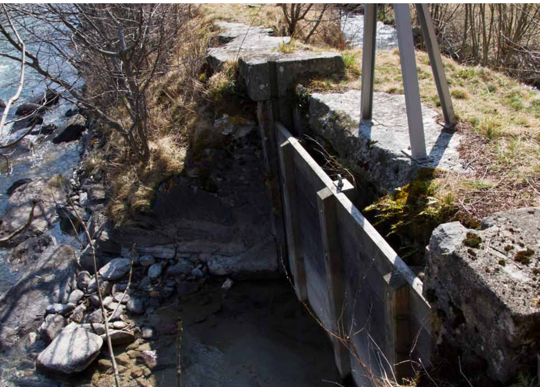
Barriera restaurata: in caso di estrema siccità permette all'Acquasela di ricevere acqua anche dal Poschiavino. Restauriertes Wehr, um hier bei extremer Trockenheit den Acquasela zusätzlich durch den Poschiavino wässern zu können.
